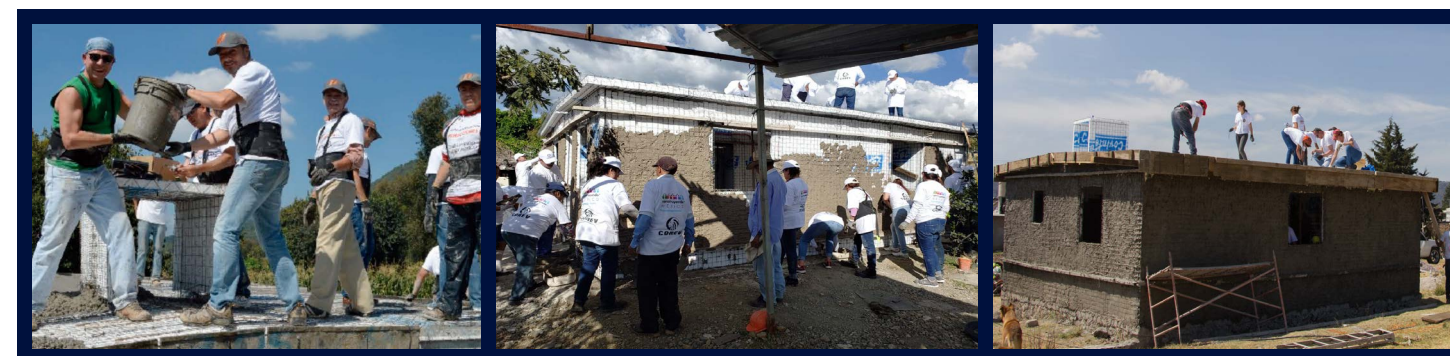
Colado de losa o techo
